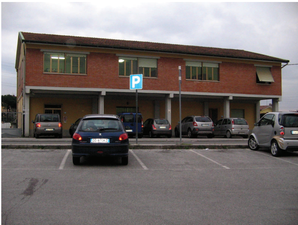
Foto 1 – Fronte nord dell'attuale complesso
