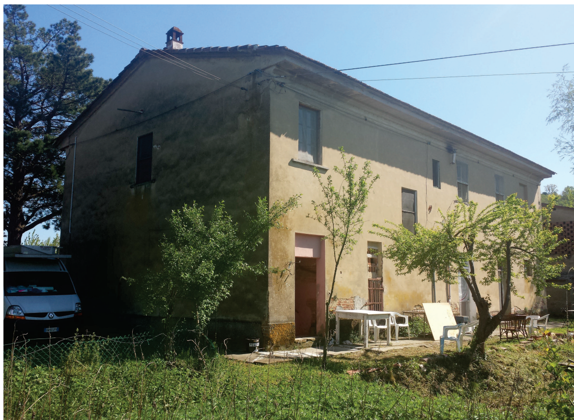
Foto n.6 – Edificio al n.96 e identificato con la lettera A - Presa fotografica esterna
