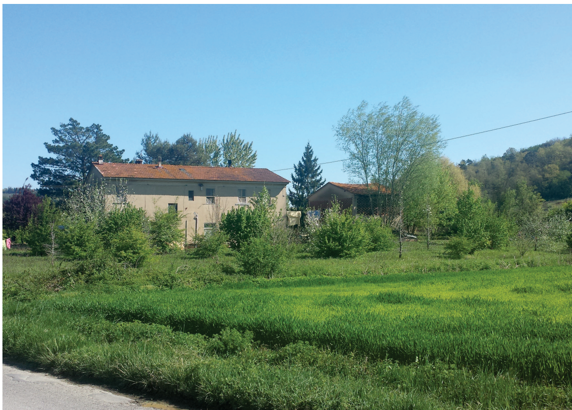
Foto n.7 – Presa fotografica esterna da nord-ovest degli edifici sottoposti a piano di recupero
