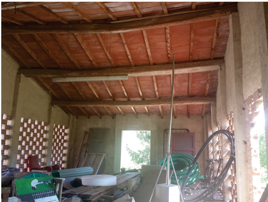
Foto n.3 – Edificio al n.96A e identificato con la lettera B - Presa fotografica interna al Piano Primo
