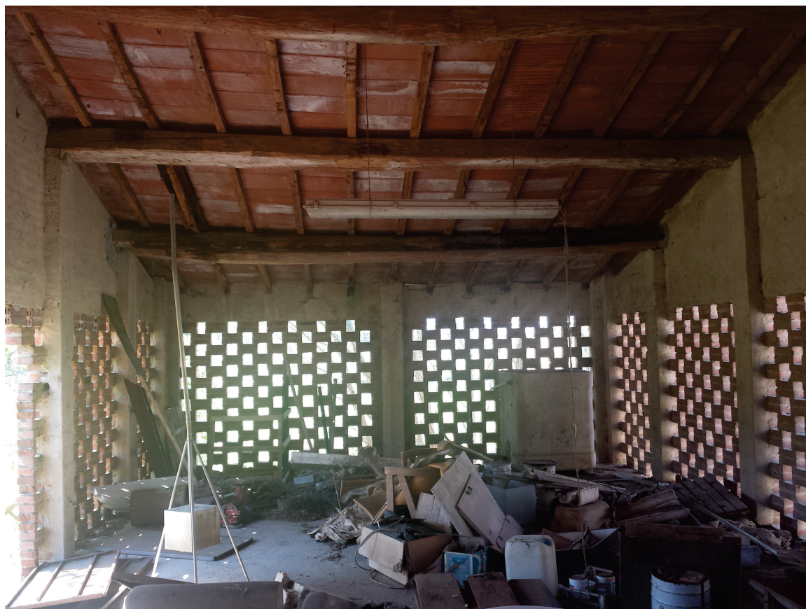
Foto n.4 – Edificio al n.96A e identificato con la lettera B - Presa fotografica interna al Piano Primo
