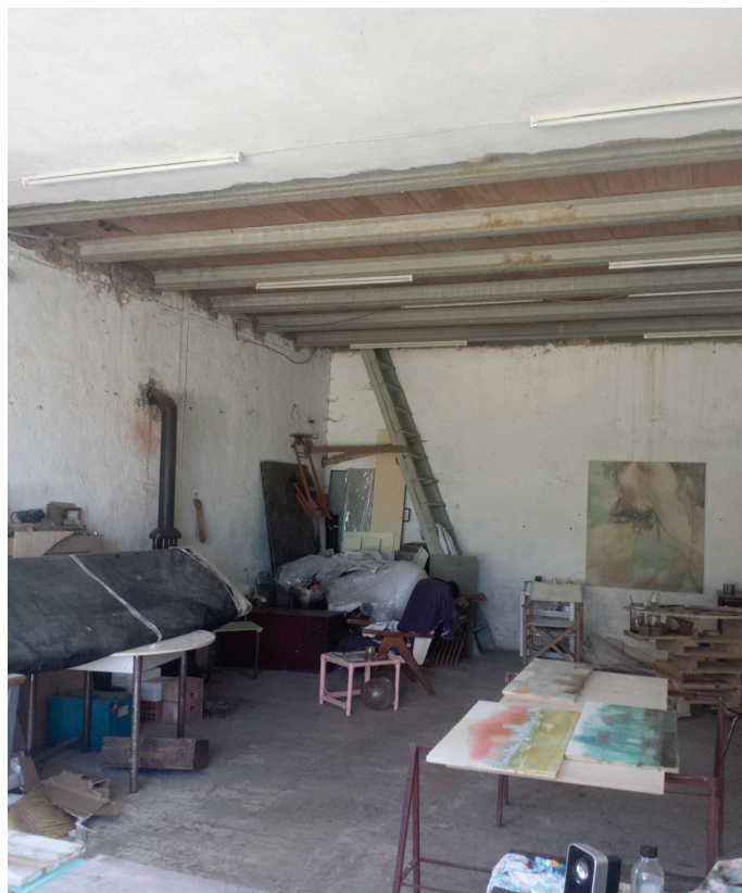
Foto n. 5 – Edificio al n.96A e identificato con la lettera B - Presa fotografica interna al Piano Terra
