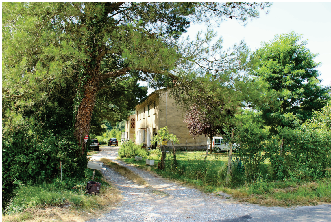
Foto n.9 – Presa fotografica esterna dal fronte della via di Chiecina degli edifici sottoposti a piano di recupero
