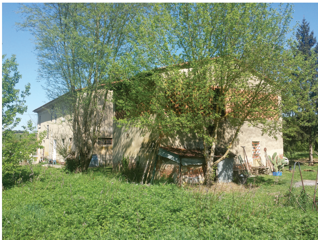
Foto n.2 – Presa fotografica esterna degli edifici sottoposti a piano di recupero
