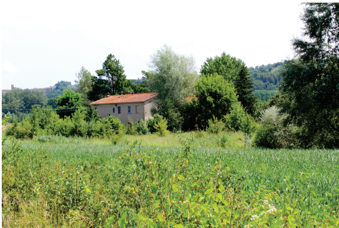
Foto n.8 – Presa fotografica esterna da sud-ovest degli edifici sottoposti a piano di recupero
