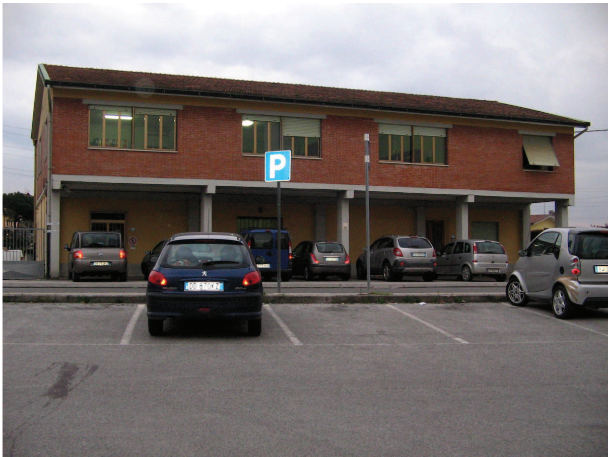
Foto 1 – Fronte nord dell'attuale complesso
