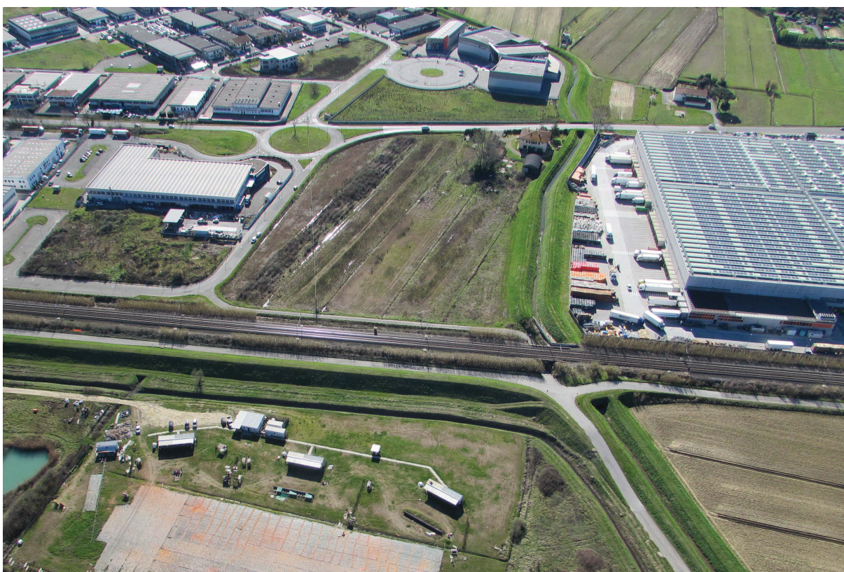
Foto 3 – Immagine aerea dell'area d'intervento con vista da Nord .
