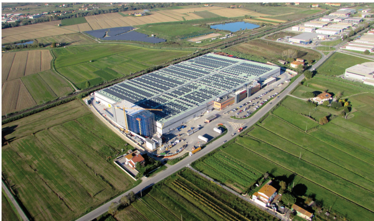
Foto 1 – Immagine aerea dell'attuale complesso ripresa da sud
