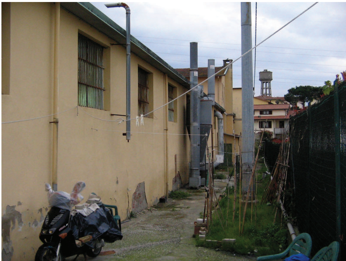
Foto 3 – Fronte ovest dell'attuale complesso
