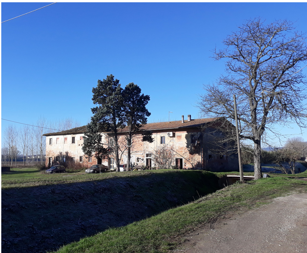
Fig. 9 – Esempio di manufatto del patrimonio edilizio posto in area di contesto fluviale del Fiume Arno
