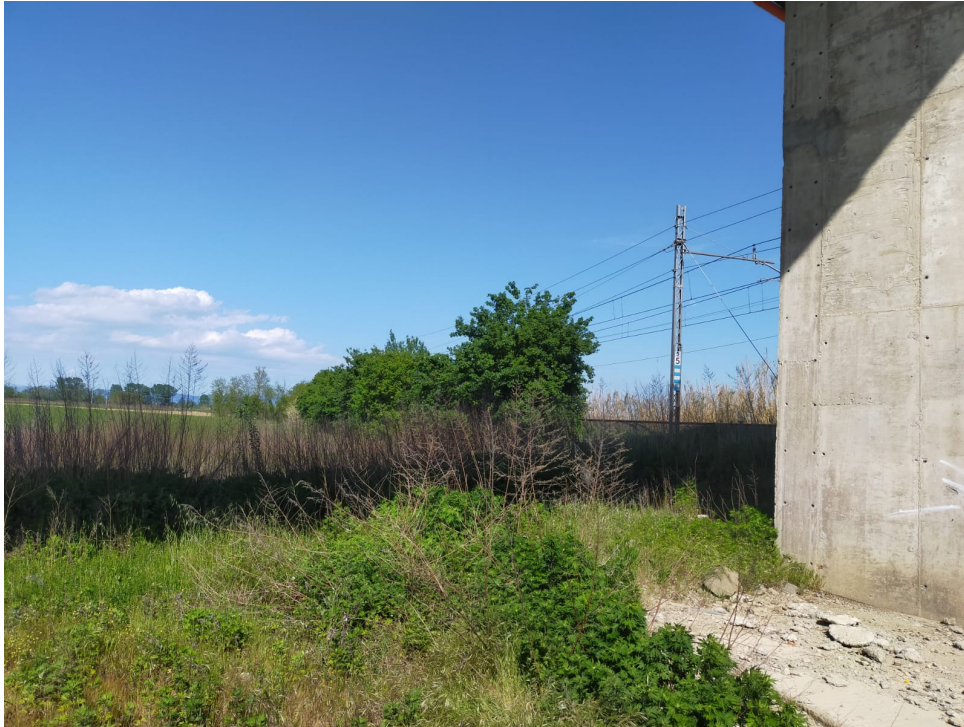
Figura 5. Vista del rilevato ferroviario dal pilone del sovrappasso stradale
