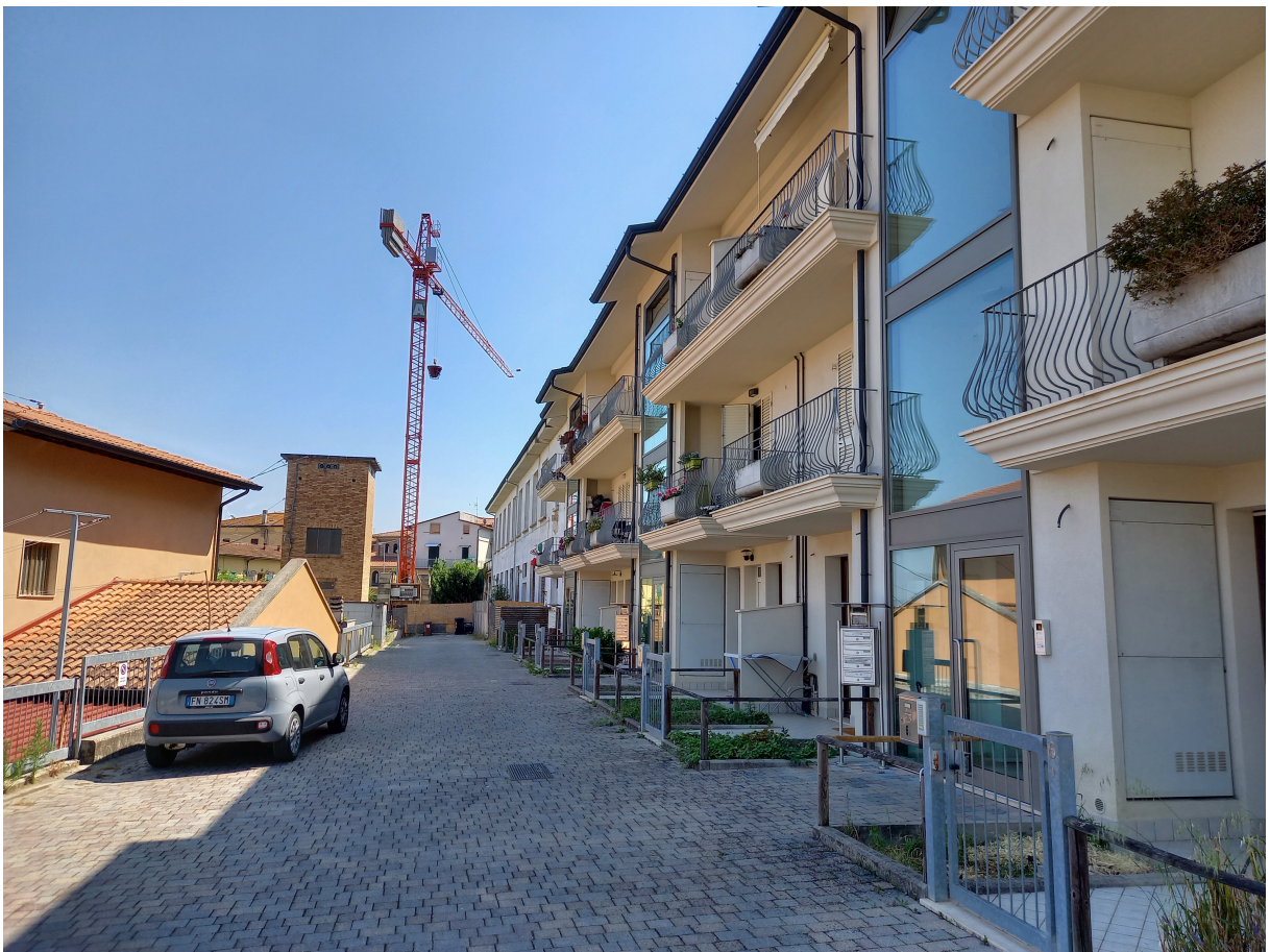
Fig. 4: Vista da Ovest comprensiva della porzione di fabbricato già recuperato in primo piano
