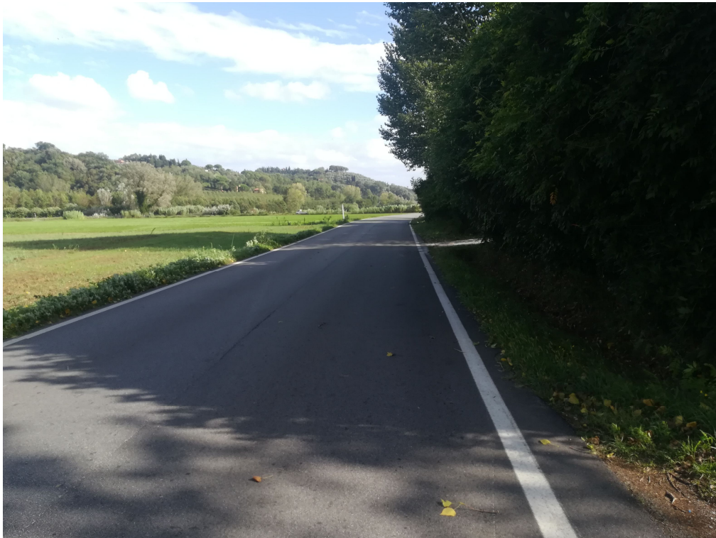
Particolare sistema viario - Direzione Montopoli V/A - foto 3
