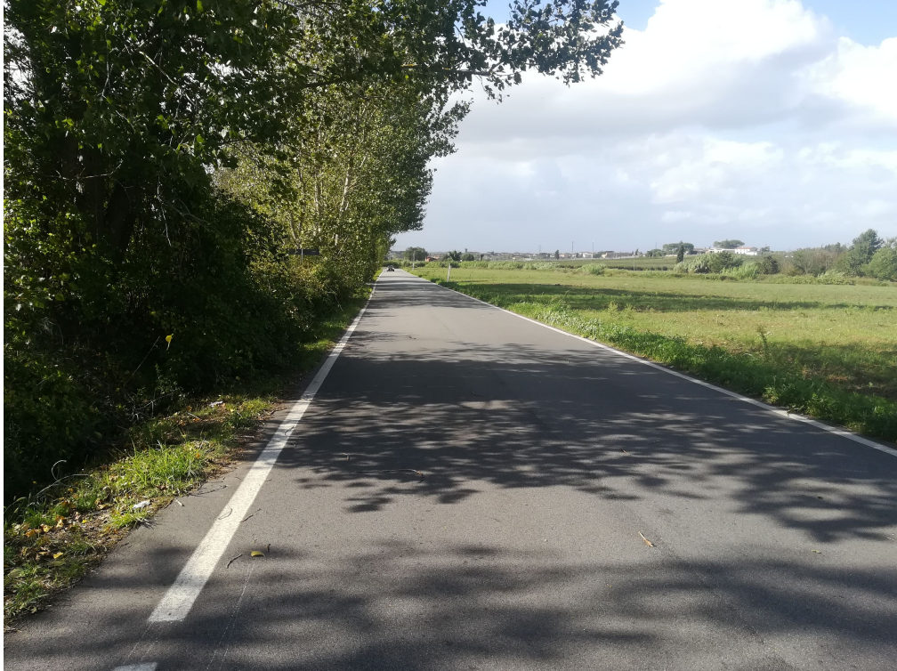
Particolare sistema viario -direzione FI.PI.LI., Capanne - foto 2
