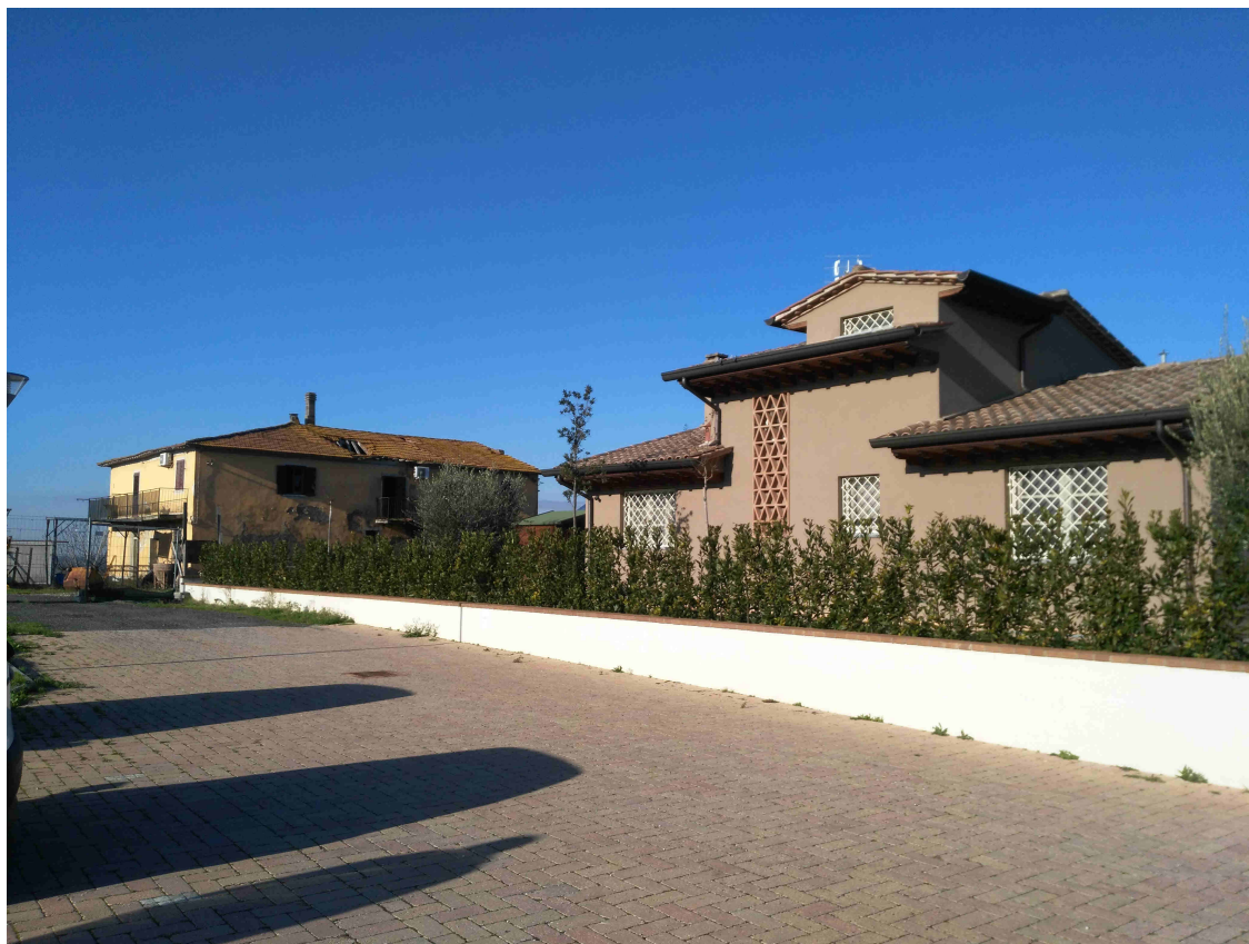
Foto n.4a – Edificio schedatura n.62 - Presa fotografica esterna da “corte Poggerello”
