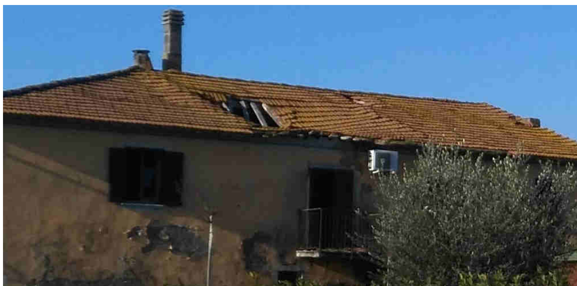
Foto n.3a – particolare copertura
