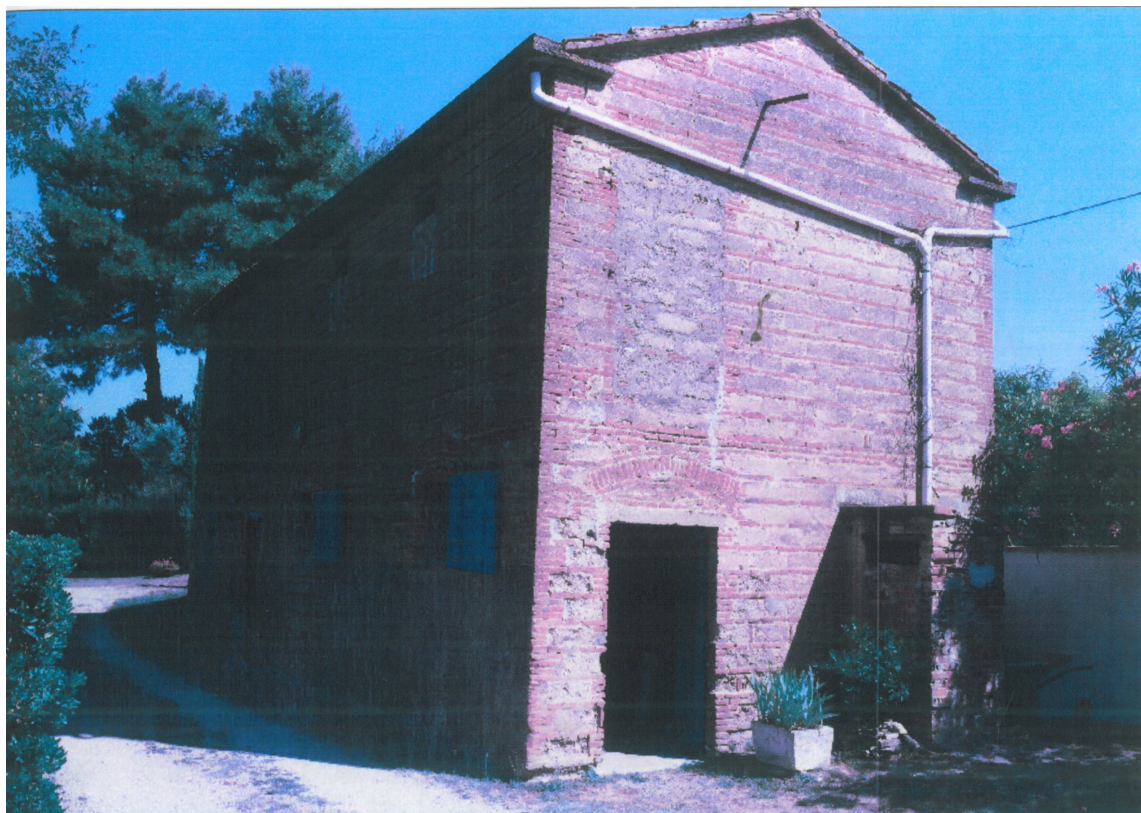
Foto n.2 – Presa fotografica esterna dell'edificio sottoposto a piano di recupero
