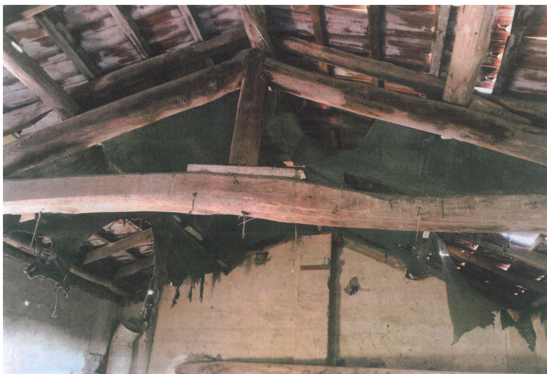
Foto n.4 – Edificio al n.33A - Presa fotografica interna copertura
