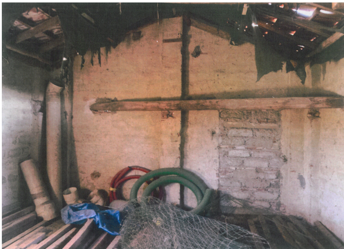
Foto n.3 – Edificio al n.33A - Presa fotografica interna al Piano Primo
