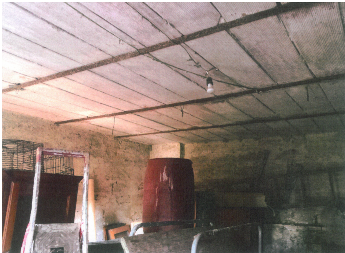
Foto n. 5 – Edificio al n.33A - Presa fotografica interna al Piano Terra
