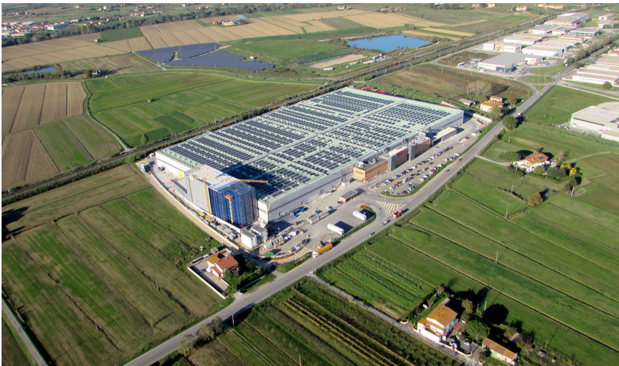
Foto 1 – Immagine aerea dell'attuale complesso ripresa da sud
