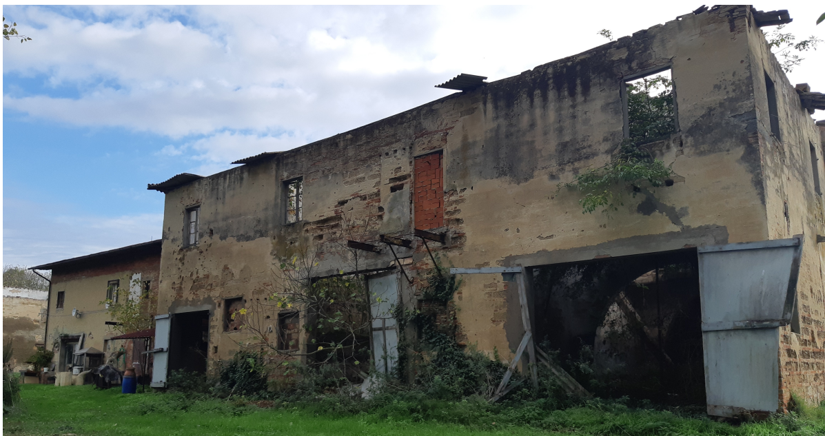
Fig. 19: Prospetto nordovest della parte del fabbricato oggetto dell'osservazione
