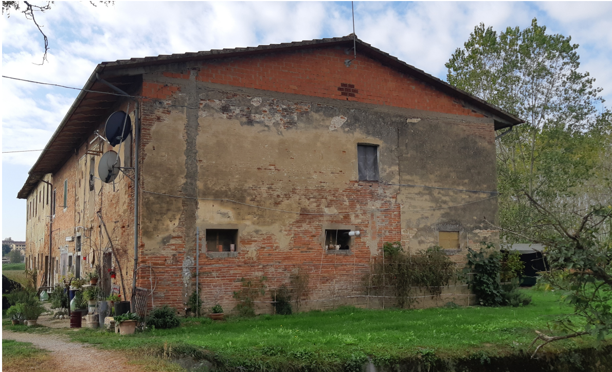
Fig. 18: Prospetto Nord-Est della parte di edificio non interessata dall'osservazione
