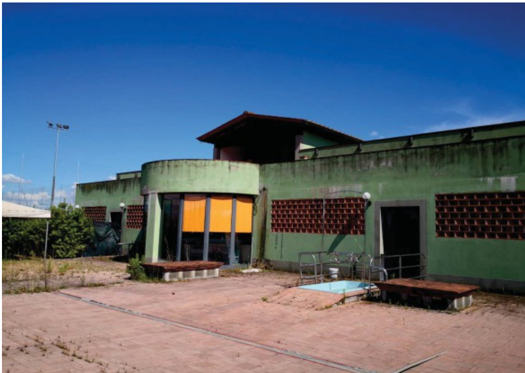
Fig. 81: Vista da Nord-Ovest (lato piscina) dell'edificio adibito a servizi per attività sportiva - Anno 2020
