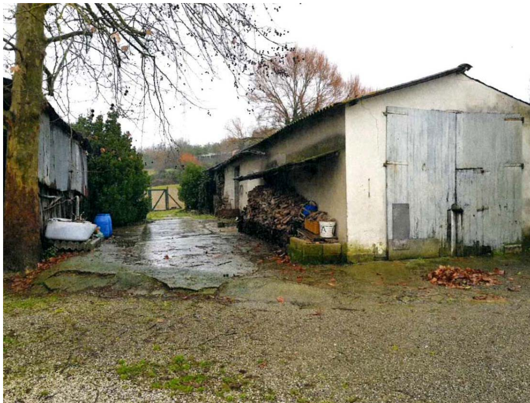
Fig. 12: Edificio esistente destinato a magazzino e deposito
