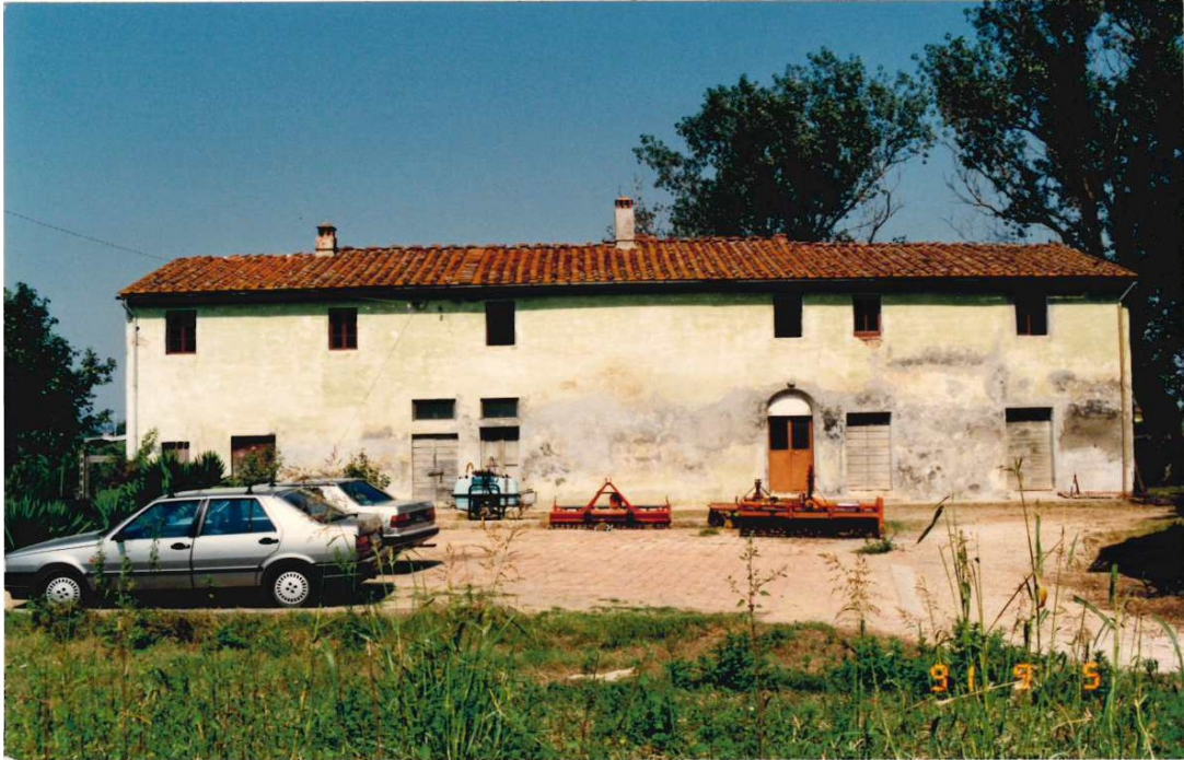
Fig. 75: Prospetto Sud (anteriore) dell'edificio originale principale - anno 1994
