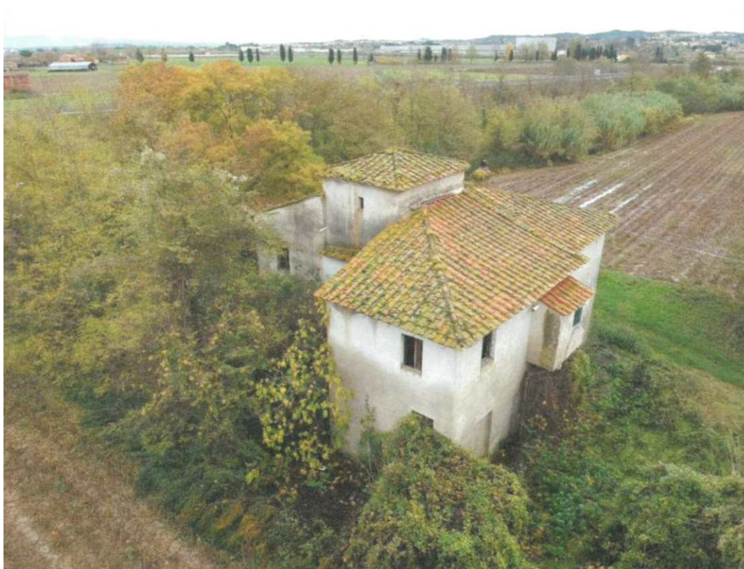
Fig. 68: Foto dall'alto da Sud-Ovest dello stato attuale dell'edificio
