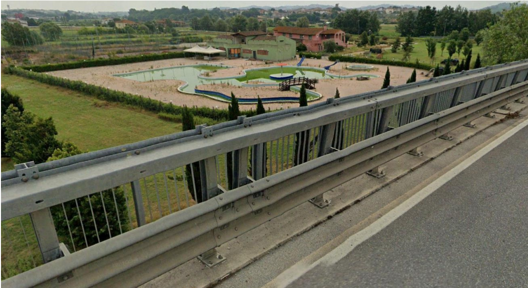
Fig. 77: Vista da Nord-Ovest del complesso Le Barbate" (ripresa dalla sommità del viadotto stradale della "Francesca bis"
