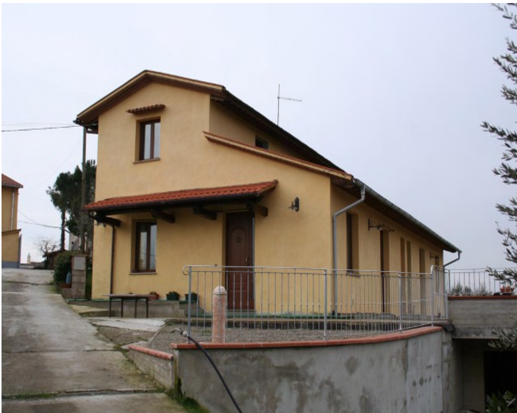
Fig. 59: Rappresentazione fotografica dello stato attuale dell'edificio normato dalla scheda n. 140A delle N.T.A. del RU
