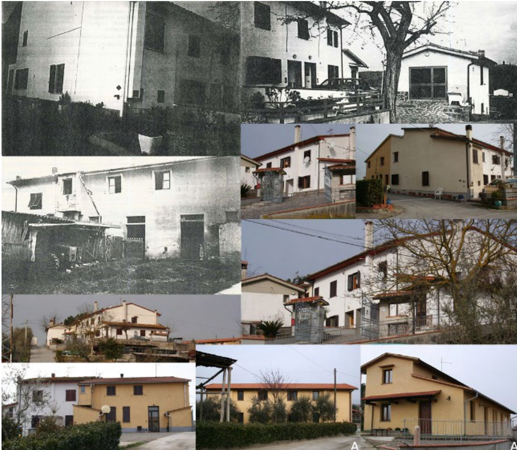
Fig. 58: Composizione fotografica sullo stato evolutivo e attuale dell'edificio normato dalla scheda n. 140 delle N.T.A. del RU
