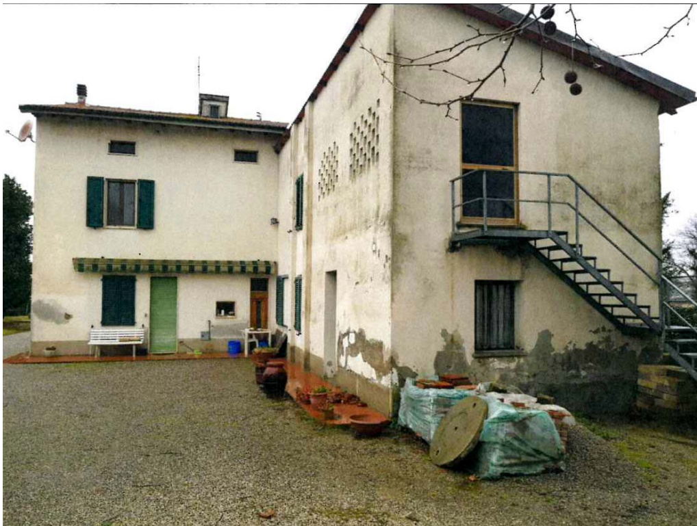
Fig. 10: Edificio esistente principale destinato a civile abitazione
