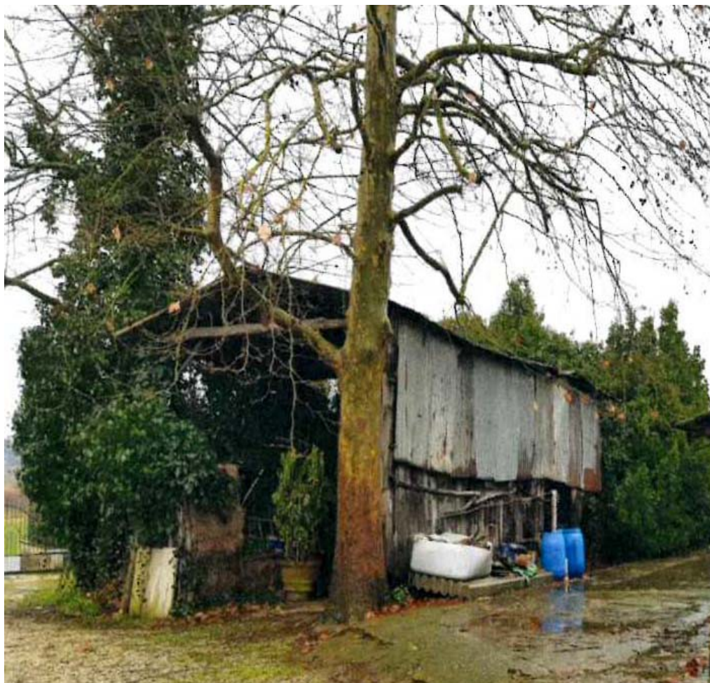
Fig. 13: Edificio esistente destinato a magazzino e deposito
