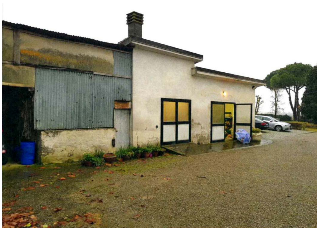
Fig. 11: Edificio esistente destinato a rimessaggio e deposito
