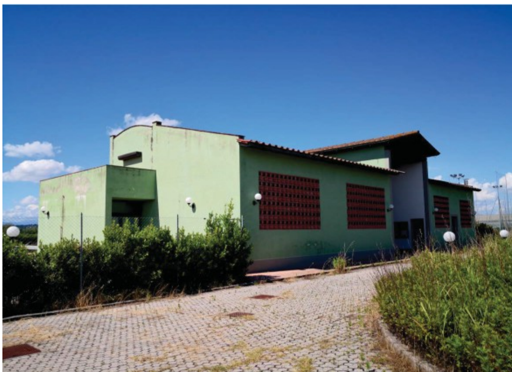
Fig. 80: Vista da Sud-Ovest dell'edificio adibito a servizi per attività sportiva - Anno 2020
