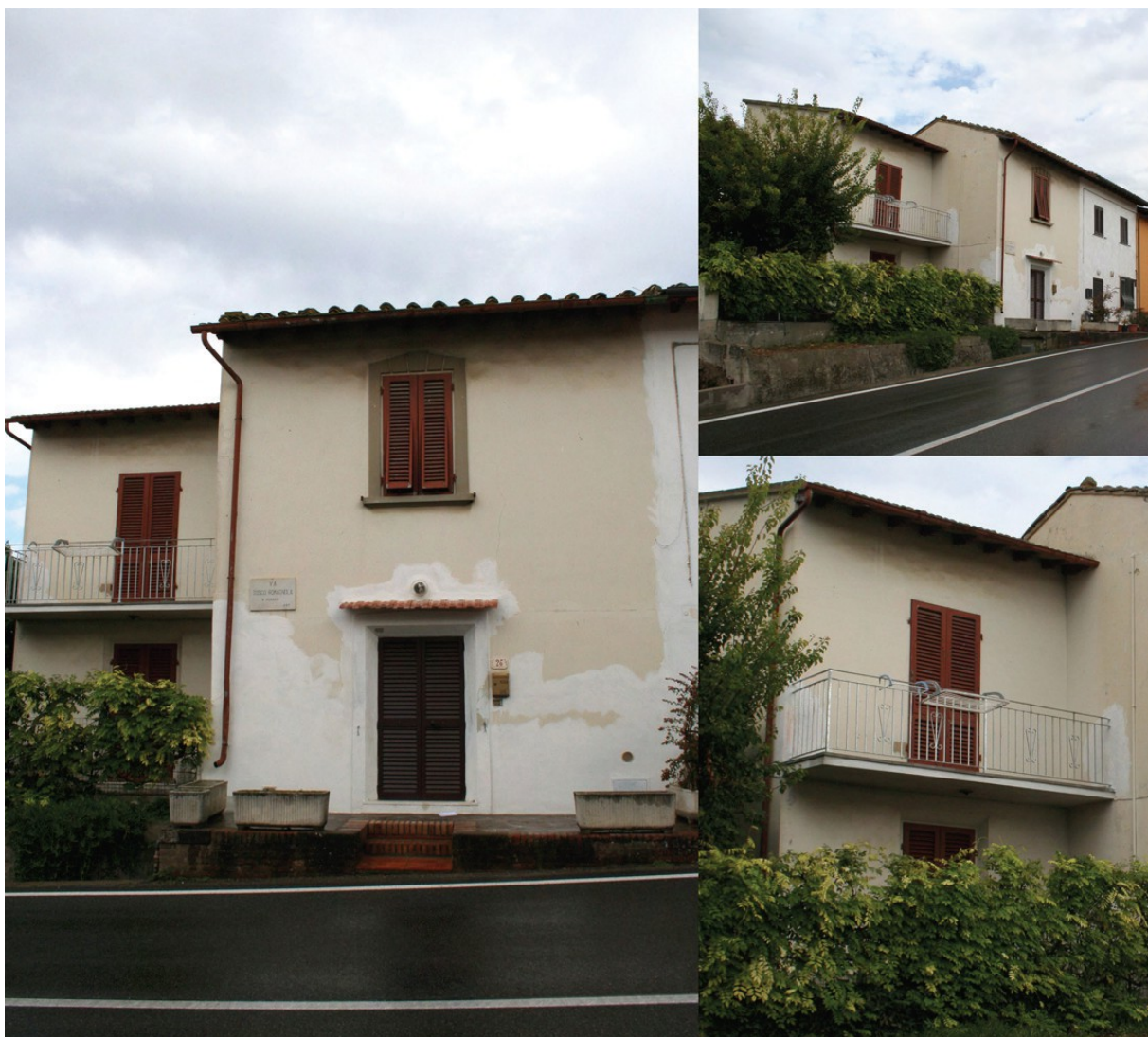
Fig. 17: Edificio oggetto di osservazione come rappresentato nella scheda-norma 129 del RU
